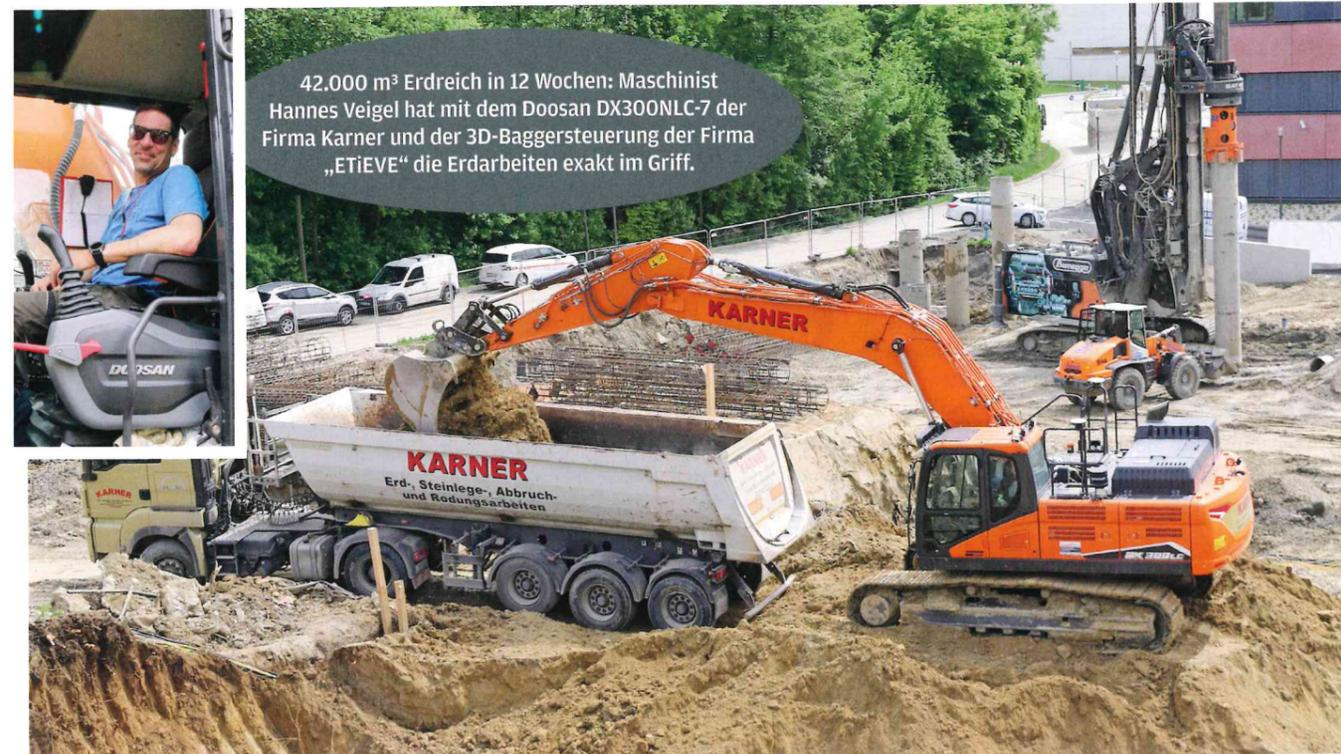
42.000 m<sup>3</sup> Erdreich in 12 Wochen: Maschinist Hannes Veigel hat mit dem Doosan DX300NLC-7 der Firma Karner und der 3D-Baggersteuerung der Firma „ETiEVE“ die Erdarbeiten exakt im Griff.
